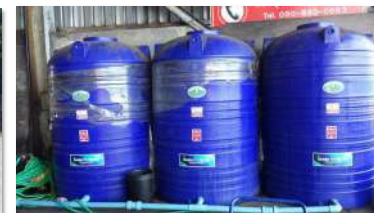
ถังกักเก็บน้ำใช้ ขนาด 3,000 ลิตร จำนวน 3 ถัง และถังเก็บน้ำใช้ขนาด 50,000 ลิตร จำนวน 1 ถัง
