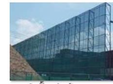
ติดตั้งตาข่ายล้อมรอบ บริเวณพื้นที่กองขึ้นไม้สับ
