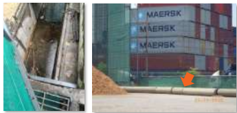
มีรางระบายน้ำรอบพื้นที่กองเก็บไม้สับ และแนวกันควบคุมการไหลของน้ำชะกองไม้สับ
