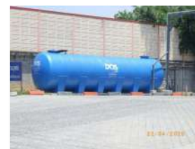
ถังกักเก็บน้ำใช้ ขนาด 3,000 ลิตร จำนวน 3 ถัง และถังเก็บน้ำใช้ขนาด 50,000 ลิตร จำนวน 1 ถัง
